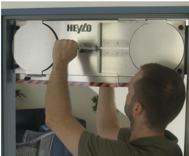
Einfache Installation der DCD-2.0 durch Schnellverschluss (Fotos: HEYLO GmbH)
