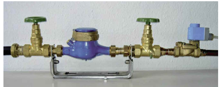
Viele Leitungswasserschadensmeldungen gehen an nur einem einzigen Tag bei den Versicherern ein. Aus einer anfänglichen kleinen Leckage wird schnell ein kostspieliger Schaden. (Foto: Stephan Tautz)
