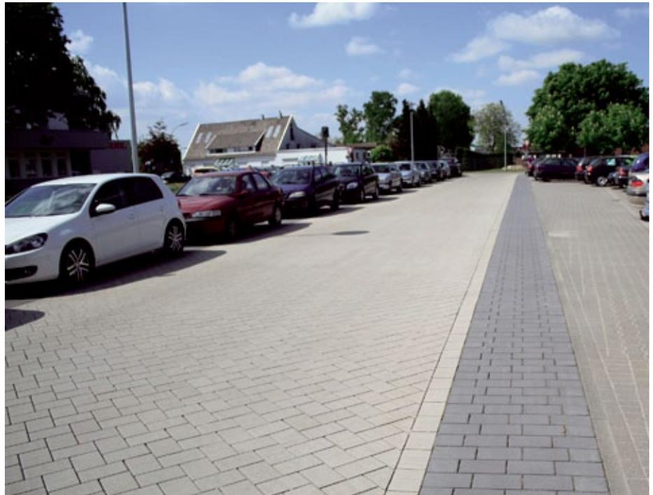
Mit Pflasterflächen aus Cheops SV Enviro Plus lässt sich Niederschlagswasser nicht nur an Ort und Stelle versickern, sondern auch reinigen. (Foto: F. C. Nüdling GmbH & Co. KG)
