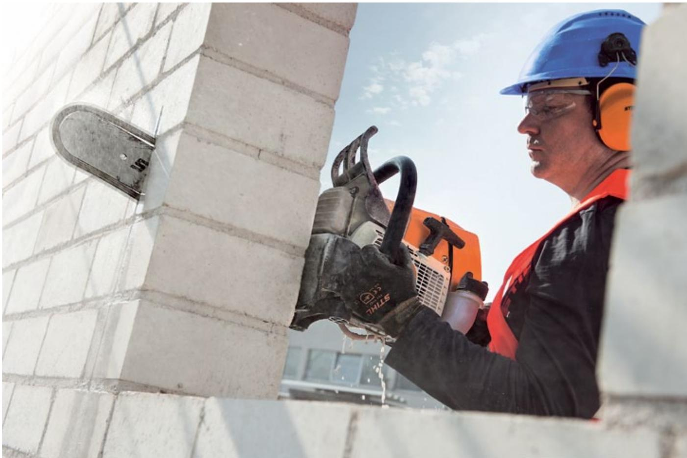
Form- oder Eckschnitte sowie Durchbrüche gehen mit dem STIHL GS 461 ohne Rüstaufwand und aufwendiges manuelles Arbeiten schnell und exakt vonstatten. (Foto: STIHL)
