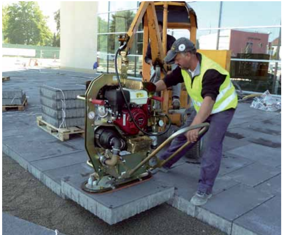
Das Vakuum-Hebeegerät POWERJET PJ 1650-b der Probst GmbH im Einsatz auf einer Baustelle in Neu-Ulm. (Foto: Probst)
