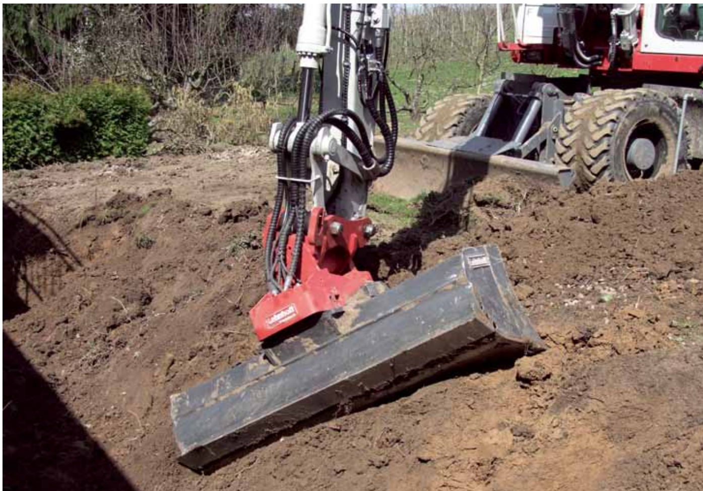
Der Lehnhoff Powertilt-Schnellwechsler schwenkt alle Anbaugeräte im GaLaBau um bis zu 2 mal 90 Grad. (Foto: Lehnhoff Hartstahl GmbH & Co. KG)
