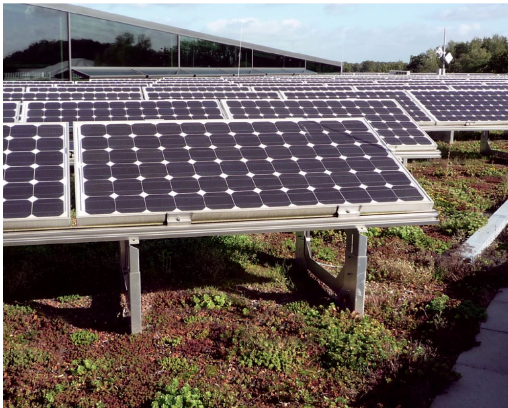
„Ohne Dachdurchdringung“ und gleichzeitig objektspezifisch anpassbar: Solarlösungen + Dachbegrünung für nahezu alle Dachsituationen. (Foto: ZinCo GmbH)
