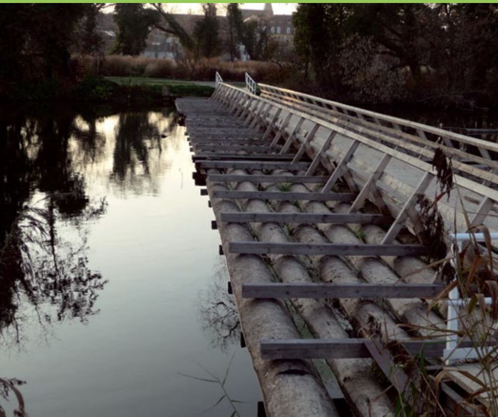
Eine schwimmende Brücke. Die Kombination aus einem Holzdeck und einem Wegebelaag vermittelt ein besonderes Gefühl für den Werkstoff Holz. Wie lange mag das Holz dem Wasser standhalten?
