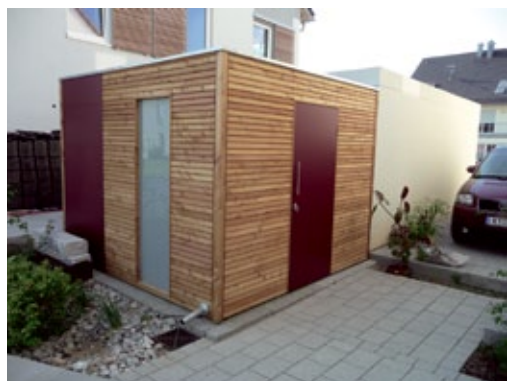
Ein modernes Holzbauwerk. Die Oberfläche strukturiert sich durch das starke Fugenbild. Der kubische Körper wird aufgelöst durch die großflächige Kombination mit Glas und einer beschichteten OSB-Platte. Durch die benachbarten warmbraunen Töne entsteht eine Farbharmonie.
