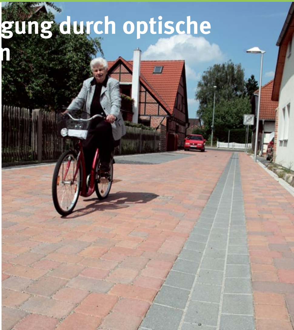
Hier haben Radfahrer Vorrang: Die Neue Straße in Pattenser Ortsteil Schulenburg gewann durch die Sanierungsmaßnahme an Attraktivität und wurde gleichzeitig mit optischen Effekten verkehrsberuhigt. (Foto: Weller Marketing)
