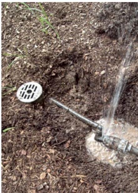
Bei der Pflege der Baumscheibe beschädigte, da zu hoch verlegte, Zuleitung zur Baumbewässerung.
