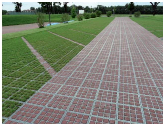
Ökologischer PKW-Parkplatz mit begrünten TTE®-Elementen und einer versickerungsaktiven Fahrgasse aus TTE®-Pflastersteinen. (Foto: HÜBNER-LEE GmbH & Co. KG)
