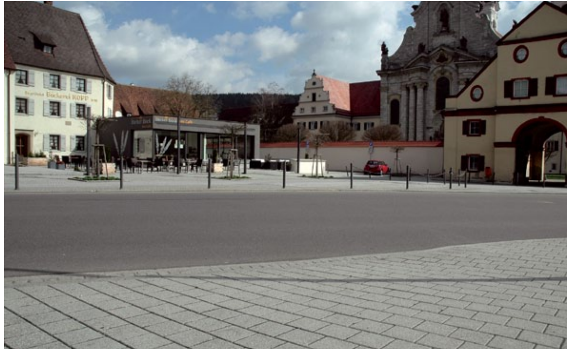
Der frisch sanierte Peterstorplatz in Zwiefalten definiert die Ortsmitte in neuer Prägung. (Foto: Einstein-Fugentechnik)
