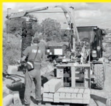
Vakuum-Bordstein-Verlegegerät JUMBO BV vario: Flexibel und kompromisslos Sicher!
