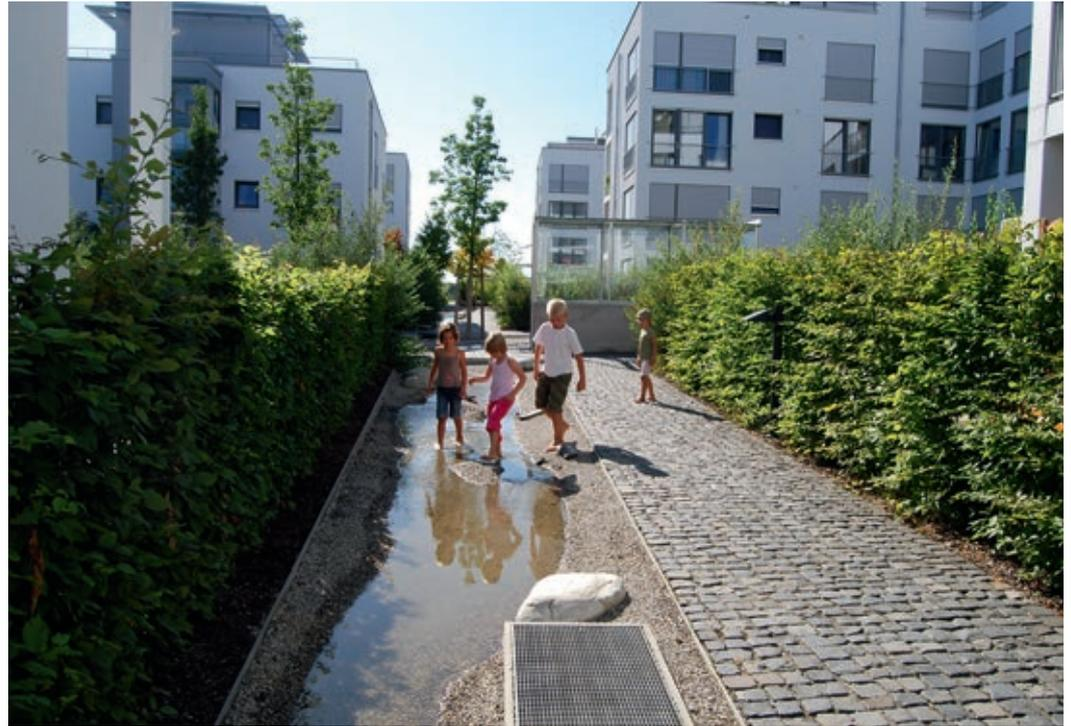
Der Wasserlauf, der sich hier gemütlich durch die Innenhöfe schlängelt, nimmt bei Regen sämtliches Niederschlagswasser in das System auf. (Fotos: ZinCo GmbH)
