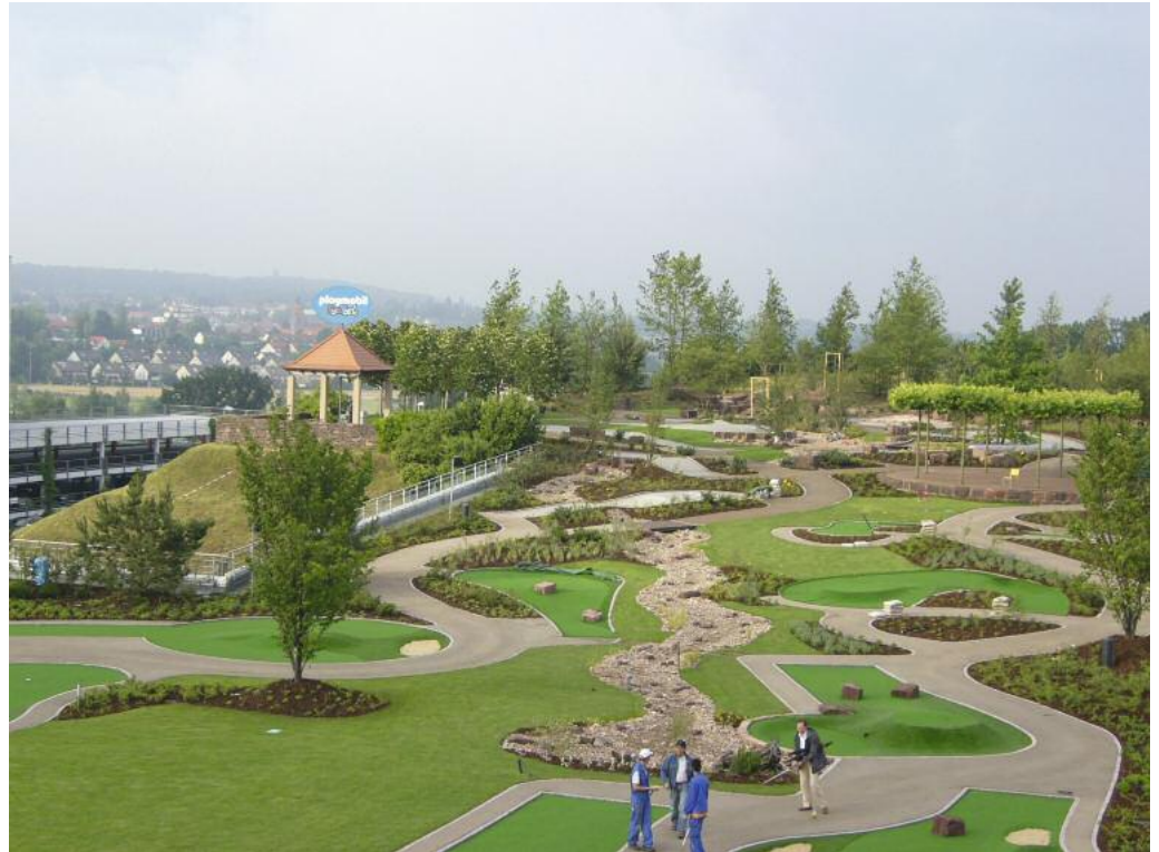
Der Betreiber des Freizeitparks in Zirndorf ließ auf einem angrenzenden Parkhausdach ein Gründach mit integrierten Mini-golf-Bahnen errichten. Als Unterlage der Dachbegrünung dienten wurzelfeste Bitumenbahnen. (Foto: Arbeitsgemeinschaft der Bitumen-Industrie e.V.)
