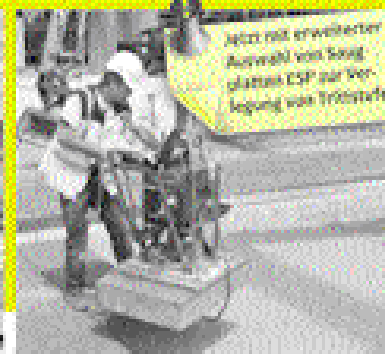
Das Vakuum-Freibordgerät QUICKJET QJ 500 e saugt selbst porösen Grenzgut schnell und sicher!
