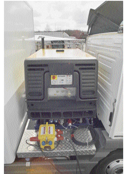
CompAir bietet serienmäßig Kufenmodelle an. Durch den eingebauten Stromgenerator wird die Maschine zur Energiezentrale des Sanierungsfahrzeuges. (Foto: CompAir Simmern)
