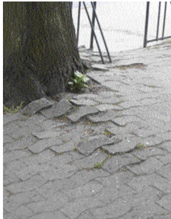
Typischer Schaden an Betonpflaster durch das Dickenwachstum der Wurzeln.
