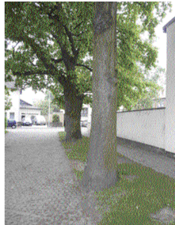
An anderer Stelle haben die Wurzeln offensichtlich im Untergrund Platz gefunden und heben das Pflaster nicht an. (Fotos: Matthias Donners)
