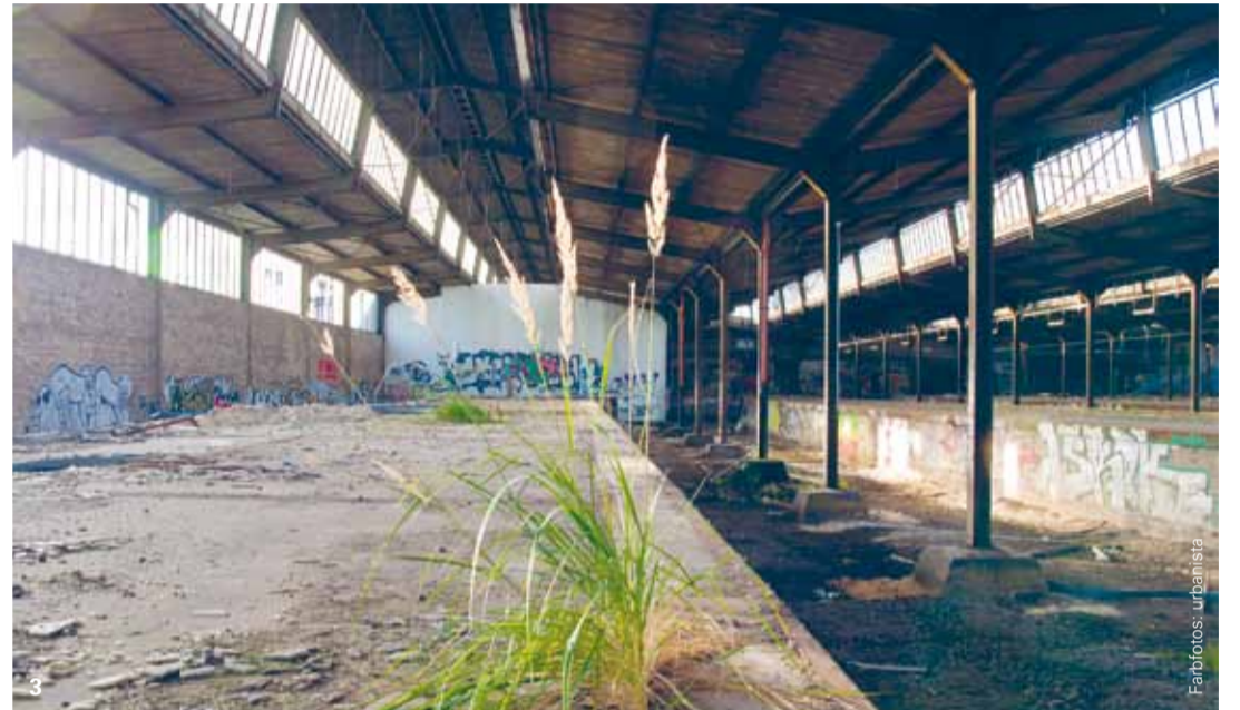
1–3 / Die großen Hallen, in denen Güter früher zunächst per Hand, später mit dem Gabelstapler umgeladen wurde, sind stark sanierungsbedürftig. Die nördliche Halle verfällt bereits sichtbar.
