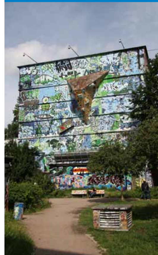
Bunker im Flora-Park.
