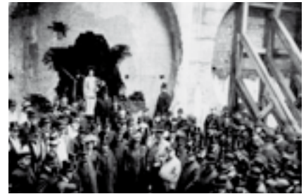
„Durchbruch“ – Alter Elbtunnel
