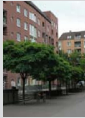
Verdichtungsbauten am Großneumarkt
