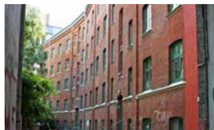
Jägerpassage: Zweiter Bauabschnitt ab Frühjahr Seite 6 - 7
