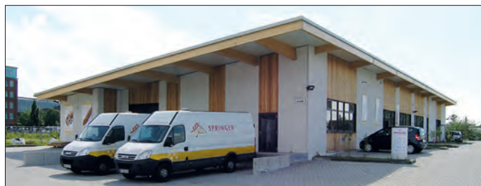
Der Neubau von Springer Bio-Backwerk in der Straße Am Stadtrand 45.
