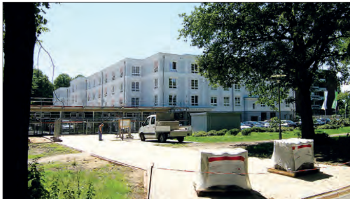
Der Neubau von Pflegen und Wohnen Holstenhof im Elfsaal 20. Links der kurz vor der Fertigstellung stehende Anbau der Kita, die im Herbst eröffnet wird. Foto: T. Richter
