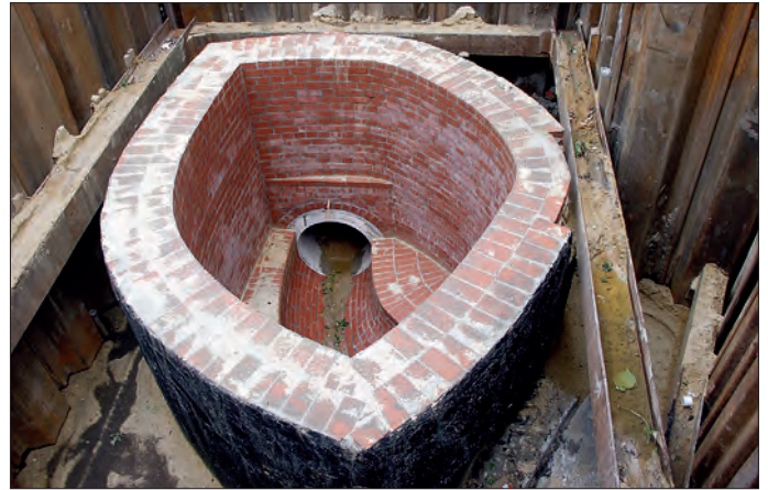
Der 2003 gemauerte Schacht.
