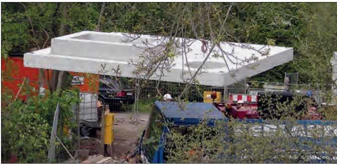
Schwertransporter in Überbreite lieferten die gewaltigen Betonfertigteile an, die von einem mobilen Kran in die Baustelle eingelassen wurden. Fotos: H. Fricke
