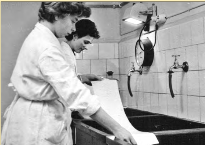
Von der Papiermaschine kamen Proben in die Dunkelkammer des Labors, wo die Qualität, wie beispielsweise die Gradation überprüft wurde.
