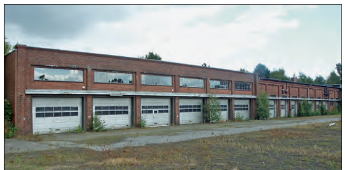
Die unter Denkmalschutz gestellten historischen Gebäude am Reitplatz wurden nach dem 2. Weltkrieg von der Verkehrsstaffel Hamburg Ost u.a. als Garagen genutzt. Von oben: Reithalle (von 1914) im Westen, Ställe im Süden und Ställe im Osten (von 1887). Fotos: H. Fricke 1995
