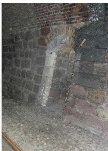
*Der Sicherheitsraum bietet Personen einen Aufenthaltsort während der Vorbeifahrt von Schienenfahrzeugen. Er dient gleichzeitig als Fluchtweg bei der Evakuierung von Fahrgästen.*
