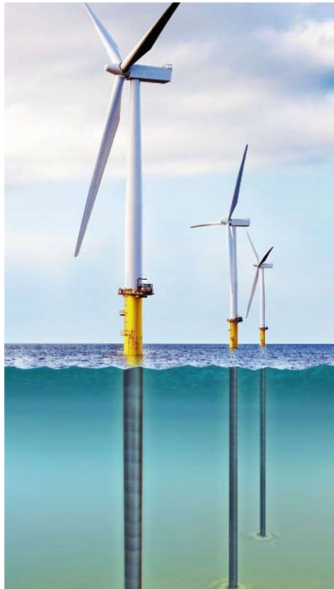
Die Monopiles von Steelwind sind bis zu sieben Metern dick
