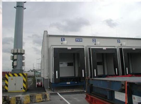
Die Schleusen müssen mit einer wirksamen Lüftungsanlage nach vollständigem Öffnen der Containertüren derart ins Freie entlüftet werden können, daß keine Schadgase in den angrenzenden Arbeitsbereich gelangen. Im Abstand von 10 m von der Abluftanlage dürfen sich keine Fenster bzw. unverschlossene Gebäudeöffnungen befinden.
