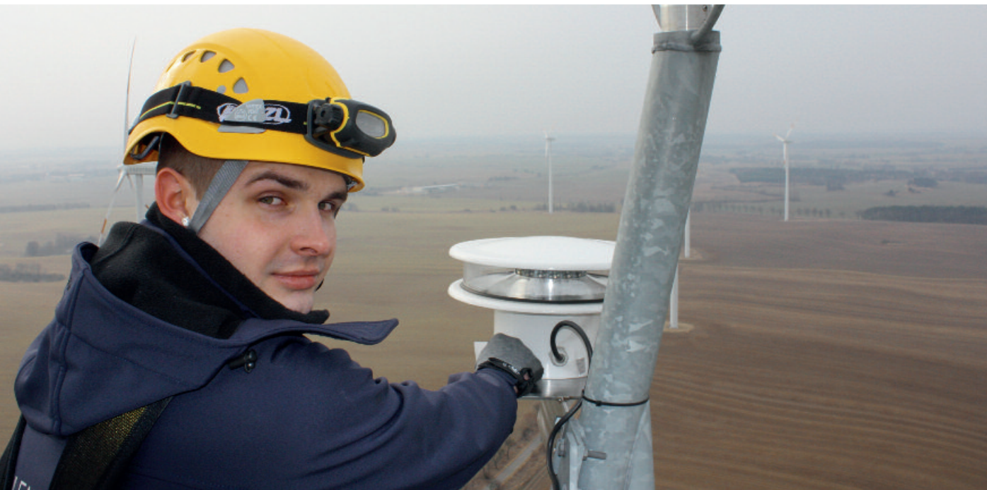
Servicetechniker bei Wartungsarbeiten in luftiger Höhe
