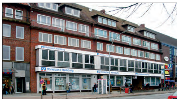
Vor der Übernahme des Grundstücks durch das Einkaufszentrum Quarree zeigte das Volksbankhaus – die Genossenschaftsbanken hatten sich zur Volksbank Hamburg vereinigt – eine geschlossene, lang gestreckte Fassade (Foto 2006).
