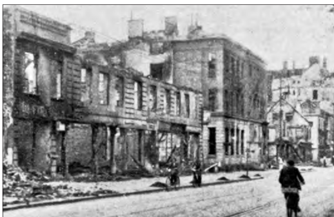
Dieselben Gebäude ausgebrannt 1945.
