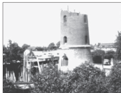
Dieses seltene Foto vom Abriss des Wasserturms am Holstenhofweg ist dem Buch entnommen.
