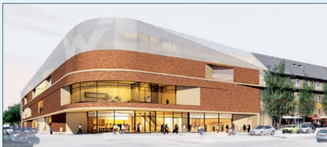
Der geplante Neubau am alten Standort von C&A, Wandsbeker Marktstraße Ecke Brauhausstraße.
