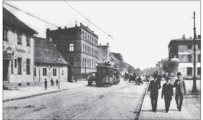
An der Landstraße nach Lübeck lagen viele Firmen. Links die Gaststätte Alter Zoll, danach folgt das Gebäude der Leonarwerke. Das Zollgebäude lag rechts.
