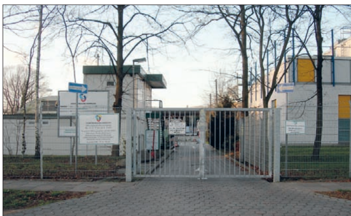
Die engen Platzverhältnisse dieser Annahmestelle für Problemabfälle in der Straße Rahlau sind eine Ursache für seine Schließung im nächsten Jahr. Foto: H. Fricke
