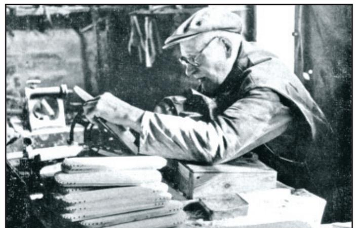
**Noch nach dem Zweiten Weltkrieg nutzte der Sägemüller Martens die Wasserkraft zum Bohren von Löchern in Bürstenhölzern.**
