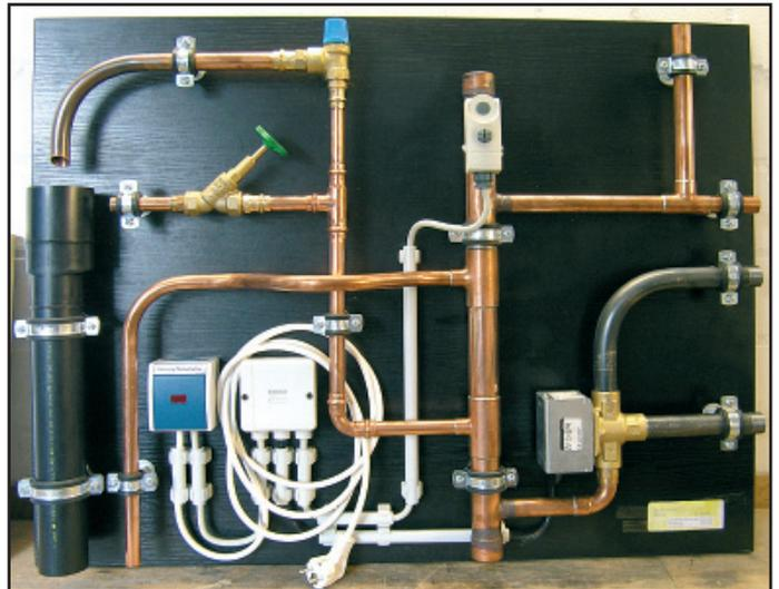
Bei dem Werkstück handelt es sich um eine Installationswand für Warmwasser, auf der verschiedene, aus mehreren Werkstoffen bestehende, Rohrleitungen mit unterschiedlichsten Verbindungstechniken (z.B. durch Hart- und Weichlöten oder durch Schweißen) wasserdicht zusammengefügt wurden. Ebenfalls wurde eine kleine Elektroinstallation mit einer Regelungskomponente für Überhitzung fachgerecht verdrahtet und angeschlossen. Fotos: T. Richter
