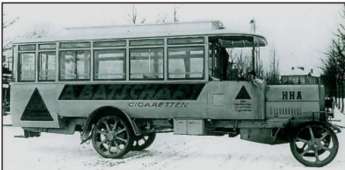
Ein Wagen der ersten HHA-Buslinie, die 1921 zwischen Schlump und Landwehr mit Vollgummibereifung fuhren. Diese Busse hatten den Einstieg an der Rückfront. Archiv HHA
