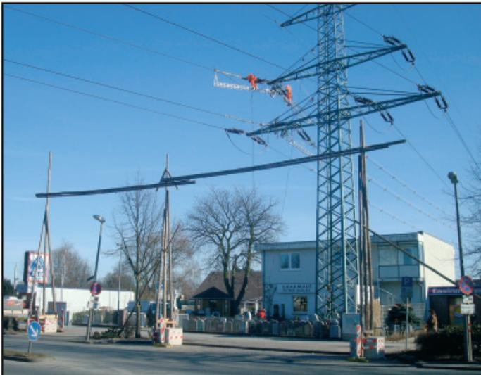
Über Tonndorf verlaufen von Süd nach Nord – so auch über den Friedhof und die Wandse – Hochspannungskabel. Nicht weil die Kabel ermüden und reißen könnten, wurden sie von Spezialisten ausgewechselt, sondern weil sie auf Dauer ihre Leitfähigkeit verlieren und es so zu Stromverlusten kommt. Mit ausgeklügelten Techniken haben die Höhenarbeiter dafür gesorgt, dass bei einem eventuellen Wegrutschen eines Kabels, unter ihnen niemand zu Schaden kommen kann. Foto Fricke
