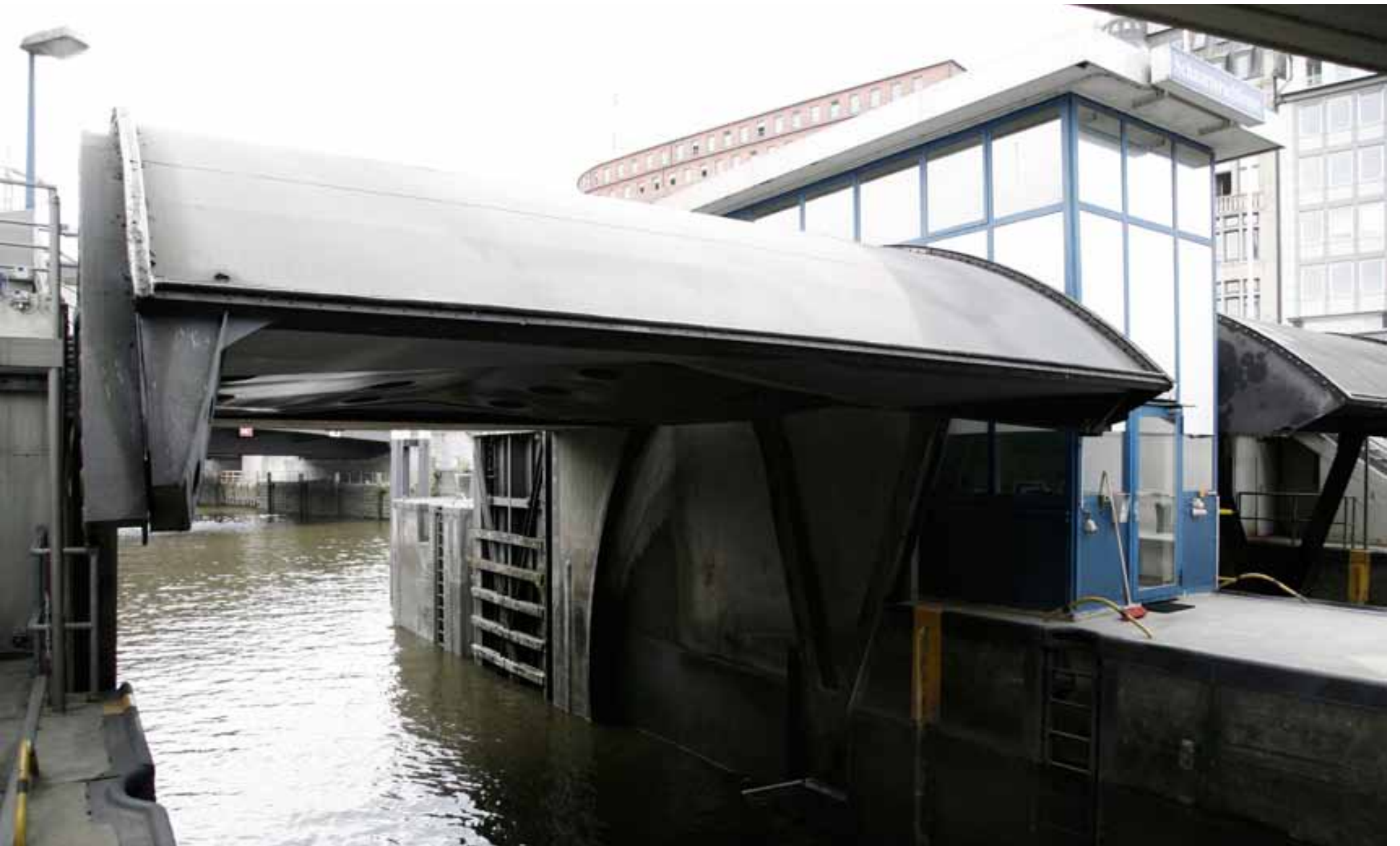
Öffnung zur Elbe – das Drehsegmenttor lässt Enten, Kanus und Barkassen durch
