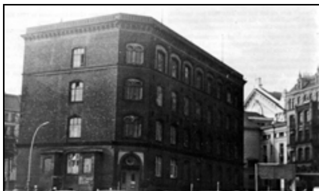
Am 3. Oktober 1877 wurde die neue Schule „Borgesch 15“ eingeweiht, so benannt, weil hier ehemals die Schweinewiese (der „Borgesch“) der Stadt Hamburg lag. Heute stehen an dieser Stelle das Magazin des Schauspielhauses und eine Tankstelle (Baumeisterstraße).
