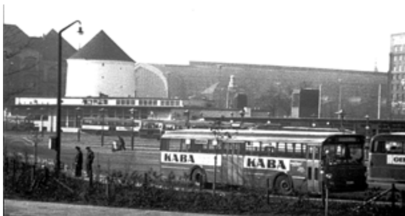
Blick in Richtung Hauptbahnhof (vom ZOB), aus: Chronik der Revierwache 18 (Teil 2), Staatsarchiv. Vor dem Abriss des „Spitzbunkers“ im Jahr 2002, war dort das Schnellrestaurant „Mc Donald“ untergebracht.
