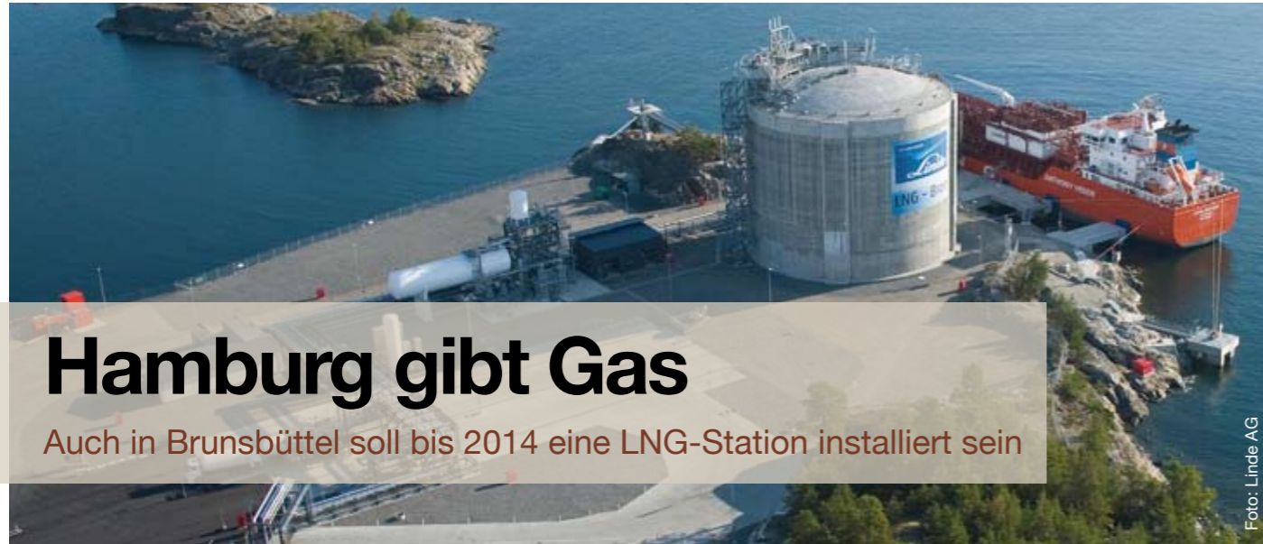
Ein LNG-Tank der Linde AG in Skandinavien: Die Isolation ist so gut, dass sich das -162 Grad kalte Gas auch nach Tagen nicht erwärmt
