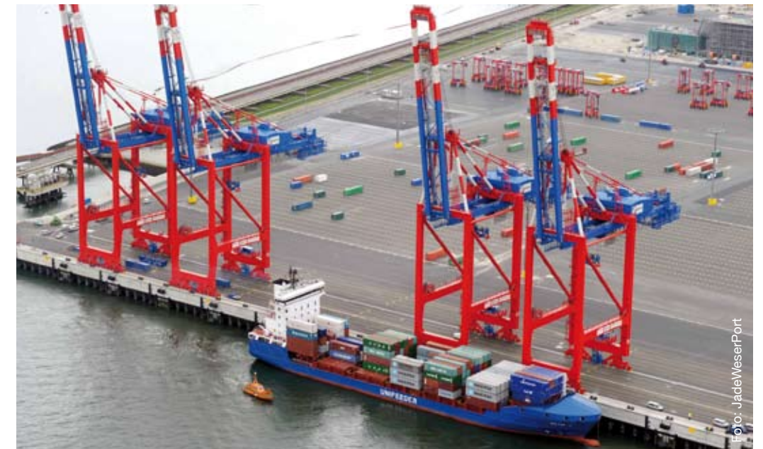
Die „Pictor J“ liegt an den ersten vier Containerbrücken des JadeWeserPorts
