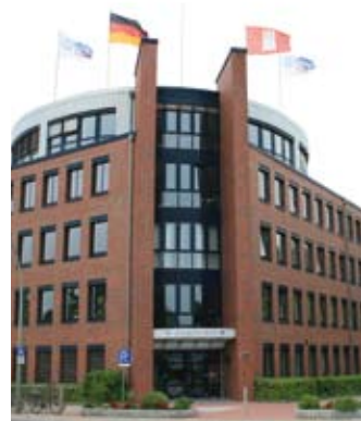
Eigenbesitz: Die Firmenzentrale
