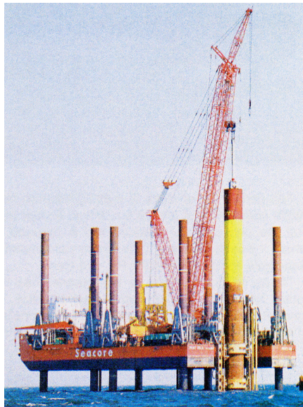
Abb. I.4.1-2: Installation Monopile Gründungsstrukturen mit traditioneller Arbeitshubinsel Offshore-Windpark North Hoyle, 2003
