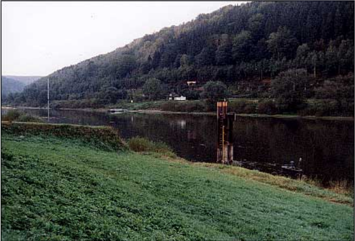
Förderpumpe der automatischen Messstation Schmilka
