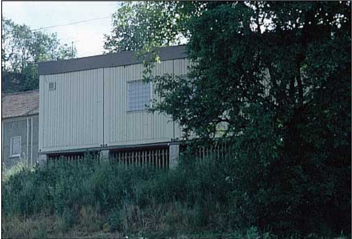
Automatische Messstation Zehren
