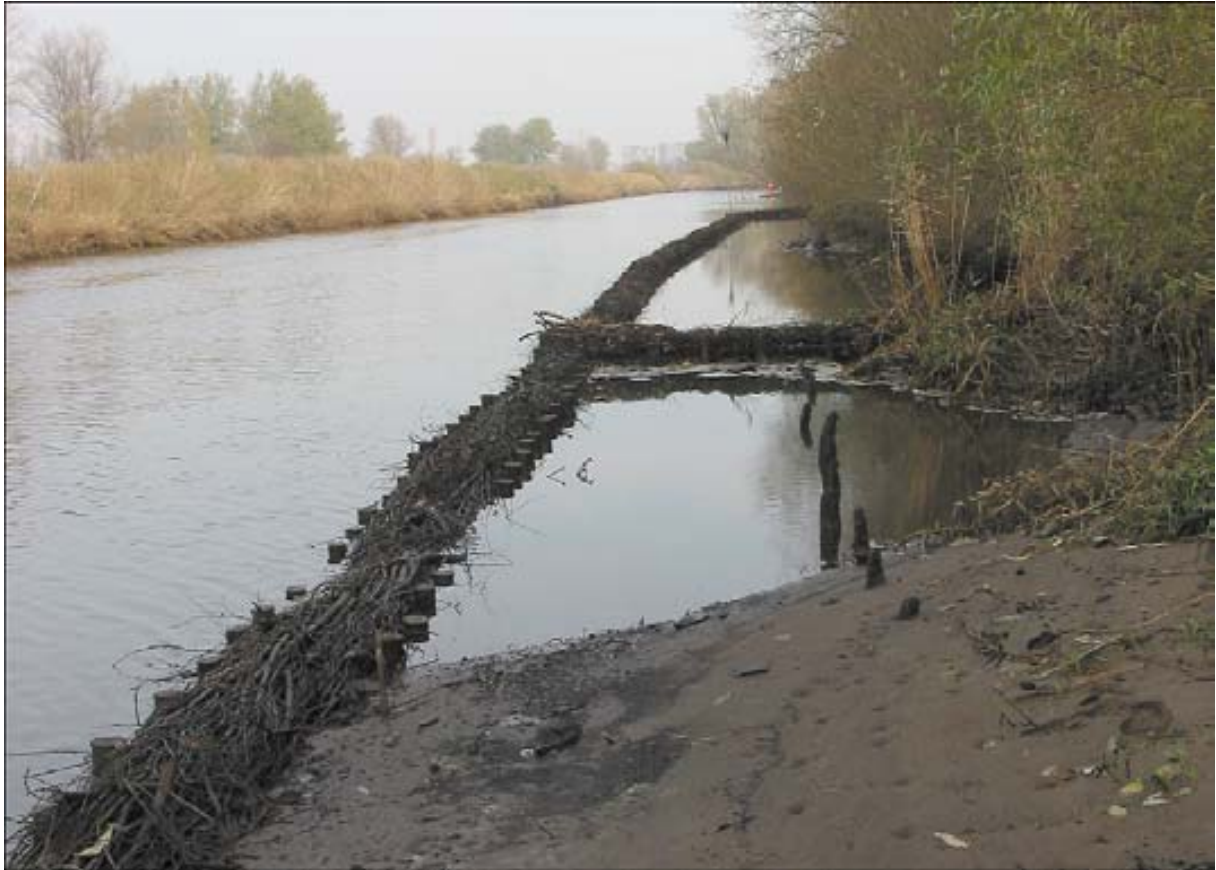
Abb. 5 Ufersicherung des WSA Cuxhaven in der Tide-Oste bei von Bremervörde
