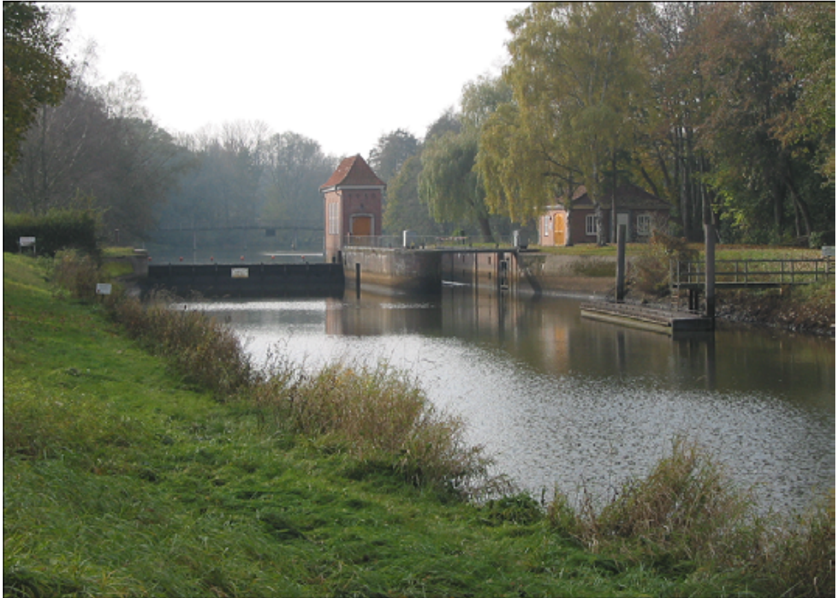
Abb. 3 Wehr- und Schleusenanlage Bremervörde - Unterwasser
