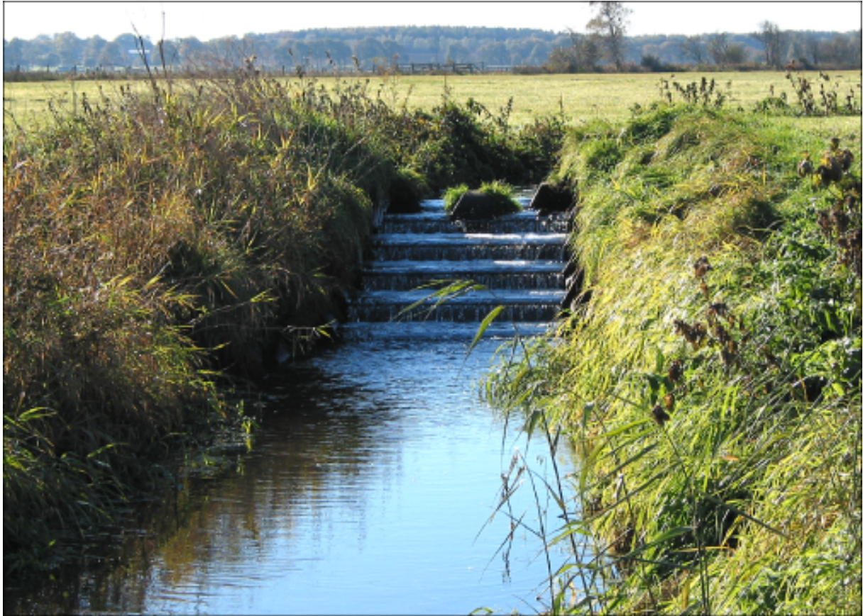
Abb. 4 Wallbeck - Kaskadenförmige Sohlabstürze im Grenzgraben Ebersdorf-Oerel (ein Quellzulauf)
