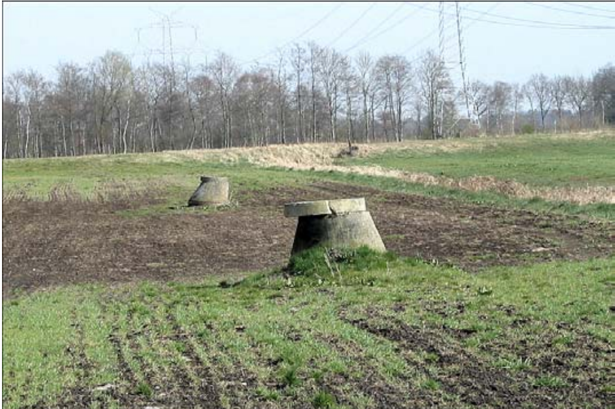
Abb. 3 Landsackungen durch Entwässerung im Einzugsgebiet der Mehe
