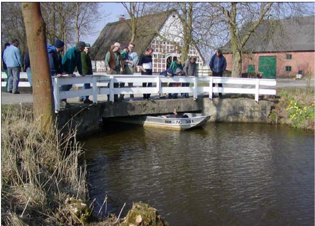
Abb. 19 Brückenunterquerung der Großen Rönne bei Rönndeich
