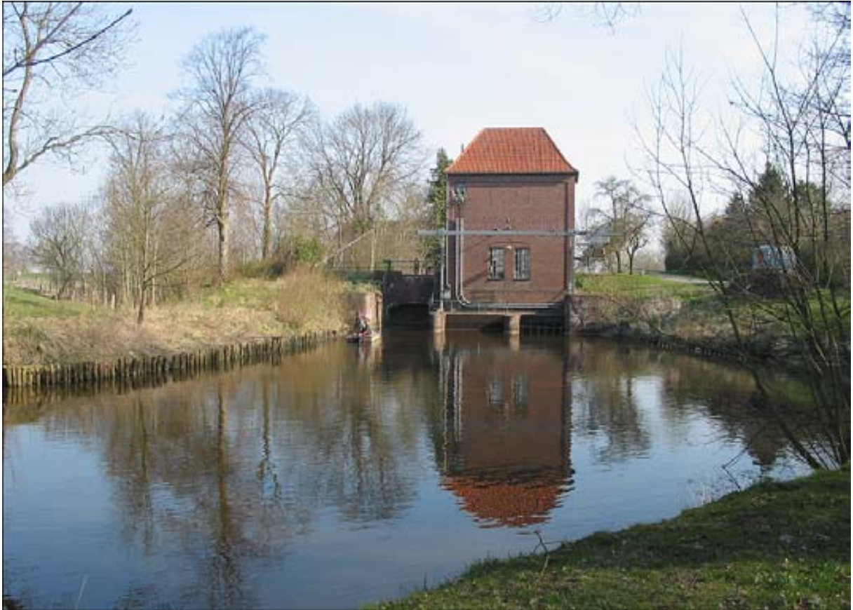
Abb. 40 Abschlussbauwerk der Aue in Neuhaus
