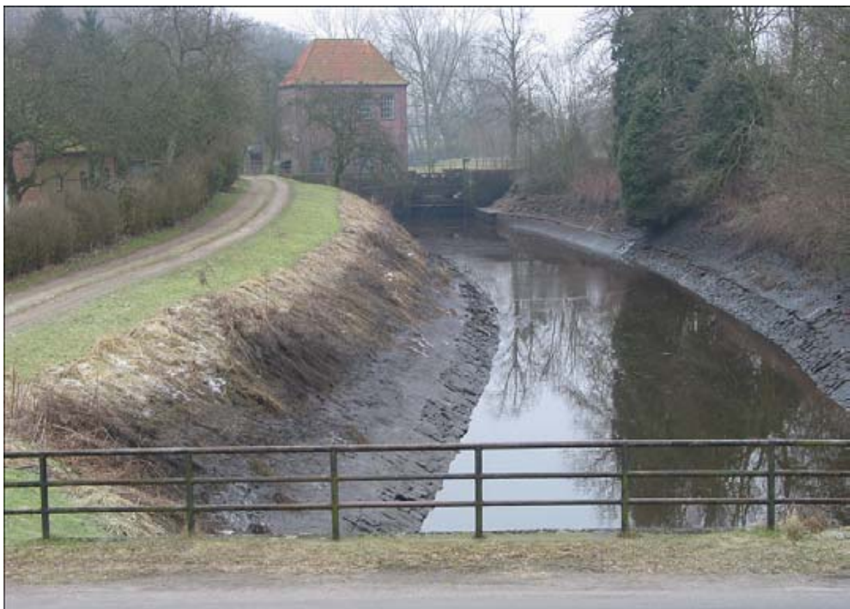
Abb. 8 Aue - Ablaufkanal zwischen Abschlussbauwerk und Hafen Neuhaus/Oste
