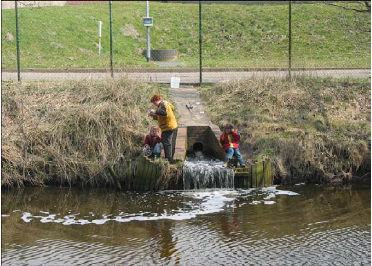
Abb. 52 Angelnde Kinder am Klärwerksauslauf Cadenberge
