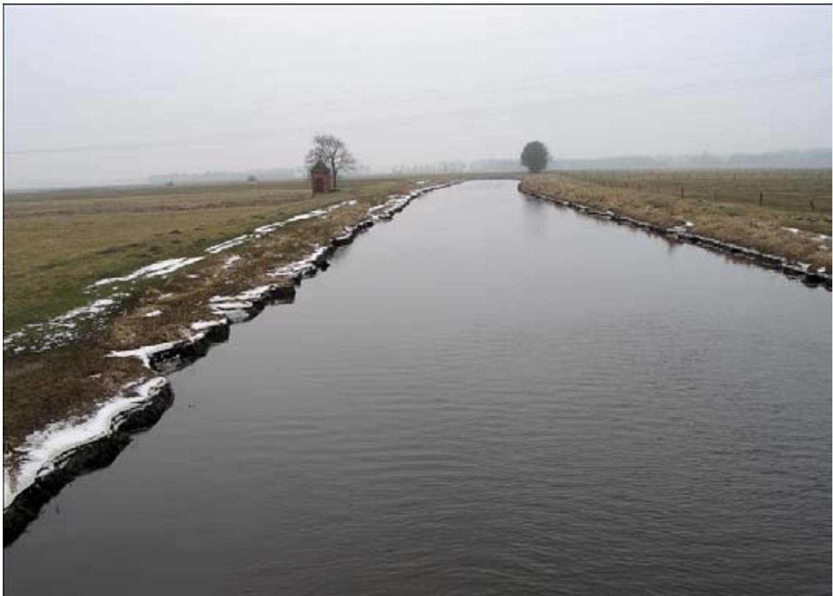
Abb. 12 Mehe - Stufenschöpfwerk bei der Mehedorfer Schiffsstelle
