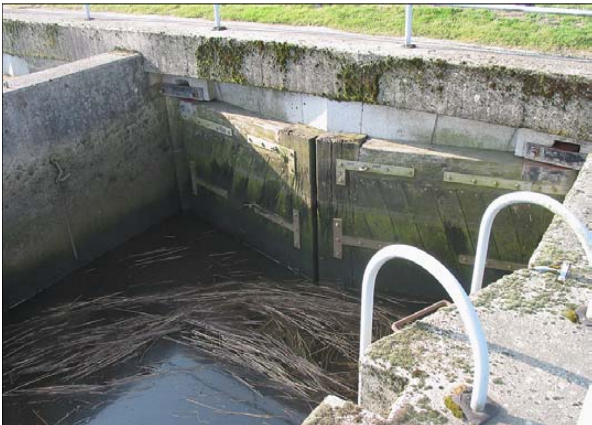
Abb. 31 Stemmtore im Abschlussbauwerk Mehe/Oste
