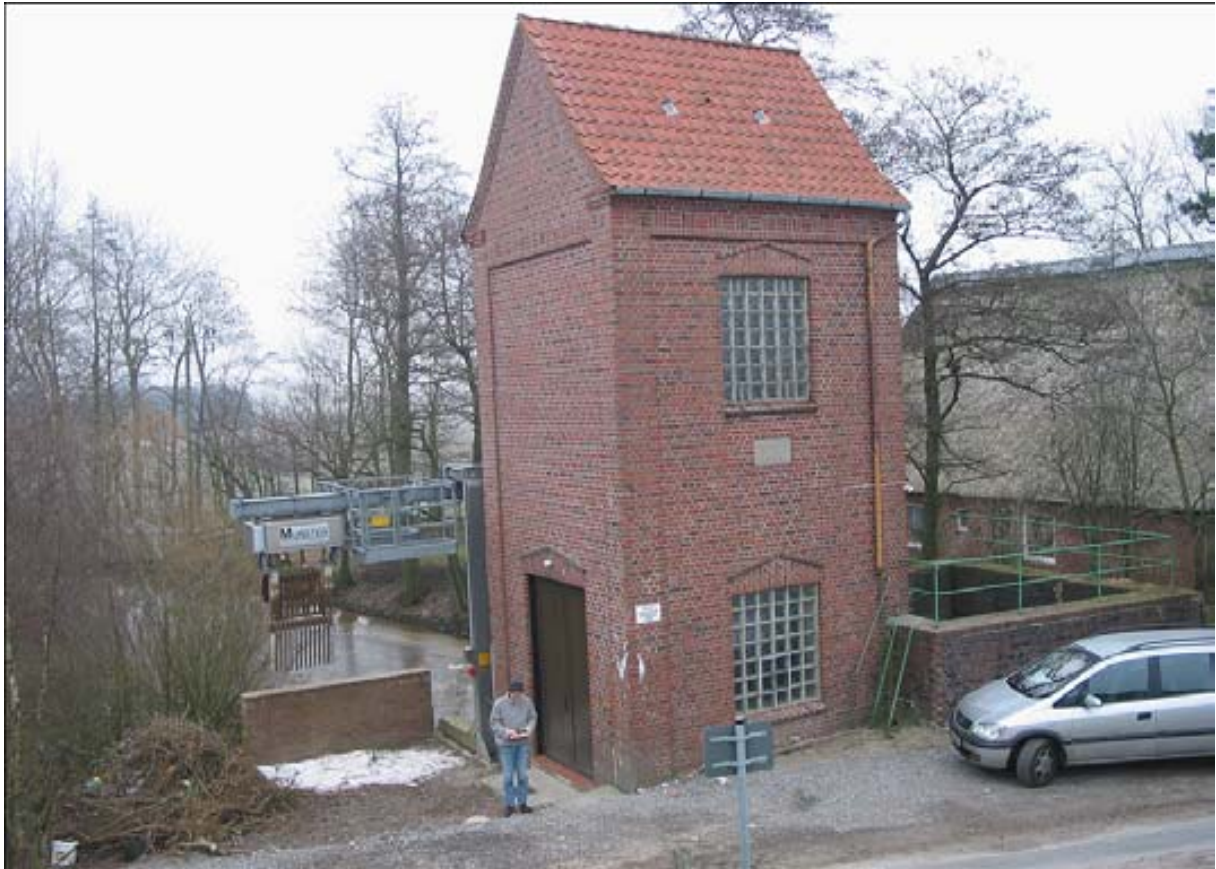
Abb. 7 Große Rönne - Abschlussbauwerk an der Mündung in die Oste (Baujahr 1937)
