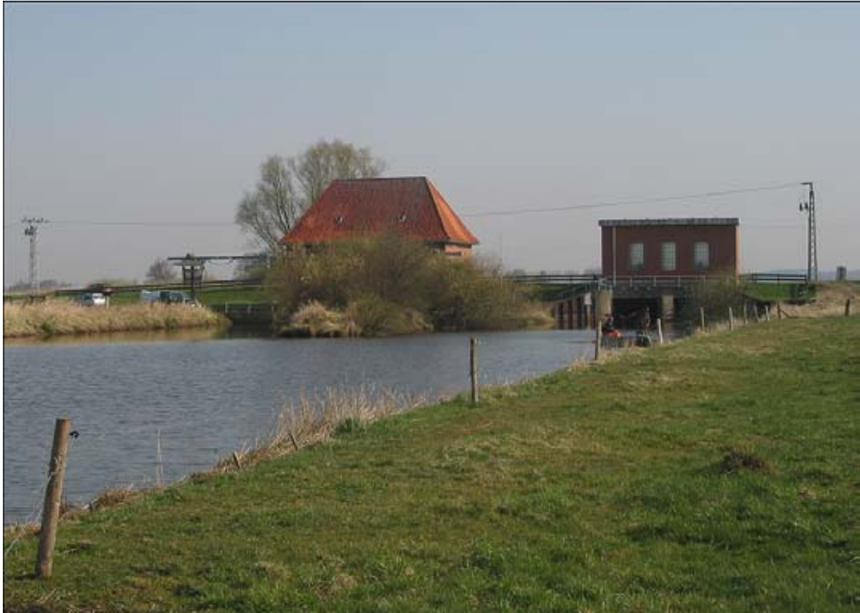
Abb. 30 Abschlussbauwerke der Mehe – links Schöpfwerk, rechts Einrichtung mit Stemmtoren
