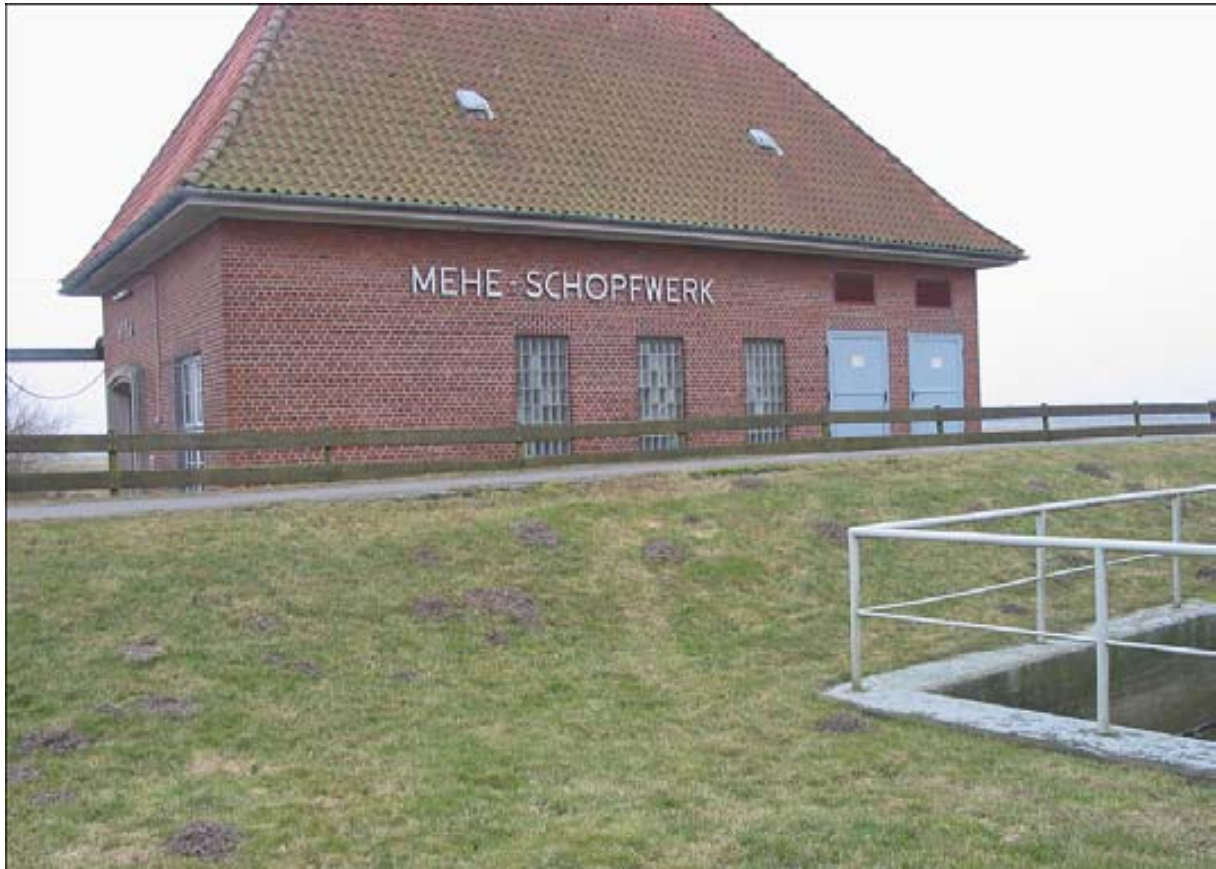
Abb. 13 Mehe - Mehe-Schöpfwerk an der Mündung zur Oste
