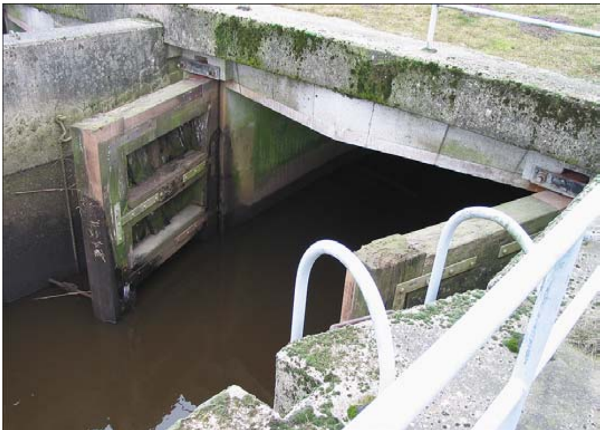
Abb. 14 Mehe - Stemmtore an der Mündung in die Oste
