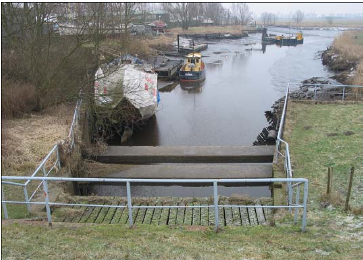
Abb. 10 Aue - Deichdurchführung des Ablaufkanals zum Hafen Neuhaus/Oste
