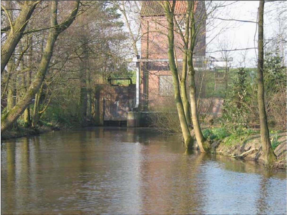
Abb. 4 Abschlussbauwerk der Großen Rönne - Binnenseite
