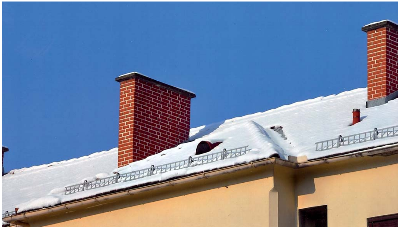
Abdeckung mit einer Betonplatte
