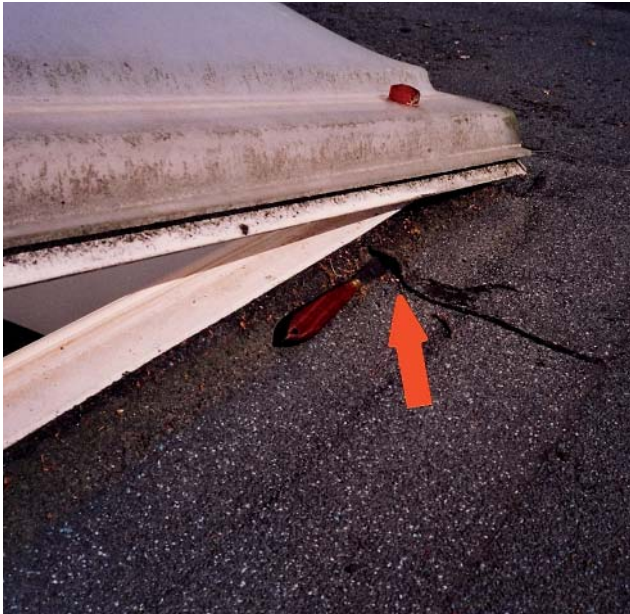
„Taschenbildung“. Zu geringe Anschlusshöhe, d.h. mind. 15 cm seitlich über die oberste Entwässerungsebene hoch geführt.
