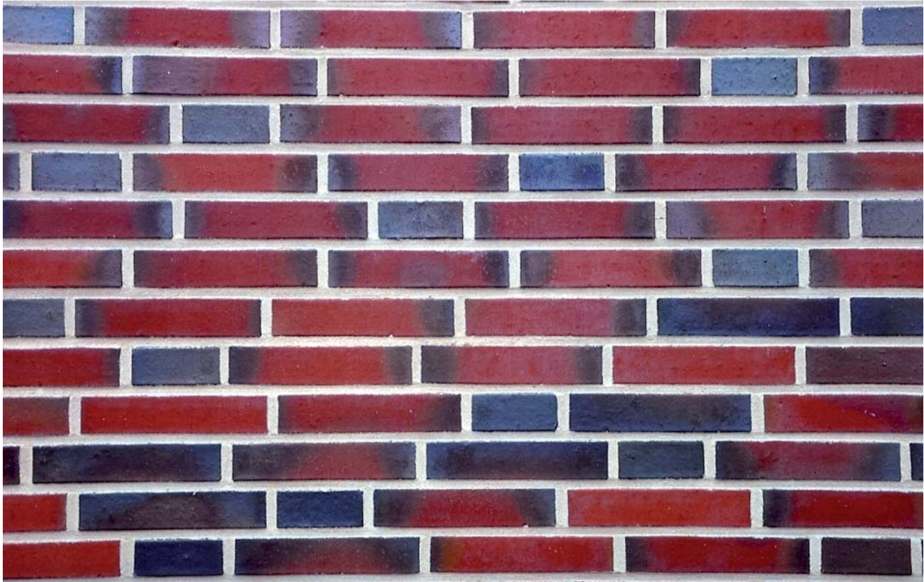
Regelgerecht ausgeführtes Dünformat-Verblendmauerwerk
