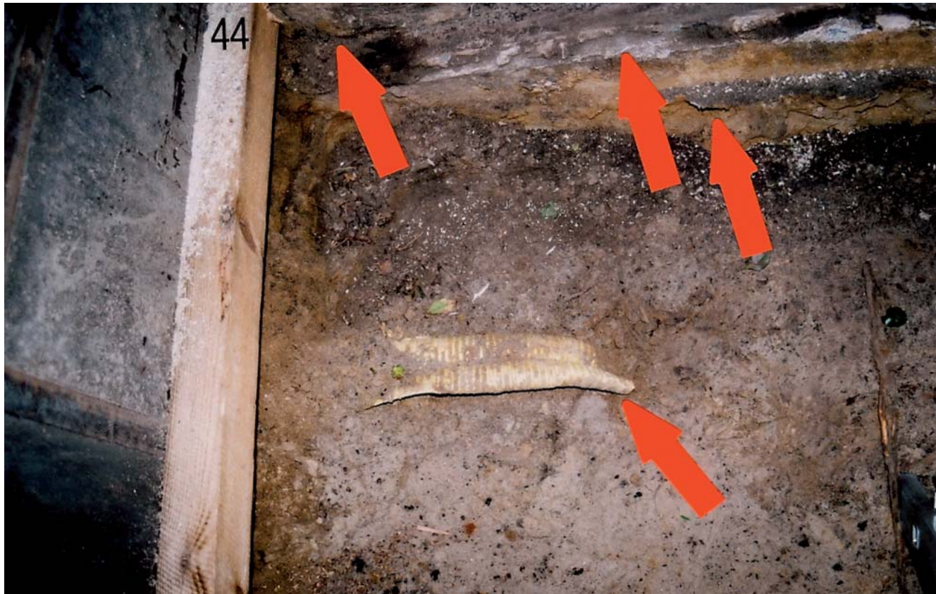
Einbau einer Drainage. Keine Fachleute. „Schmeiss rein und mach zu“
