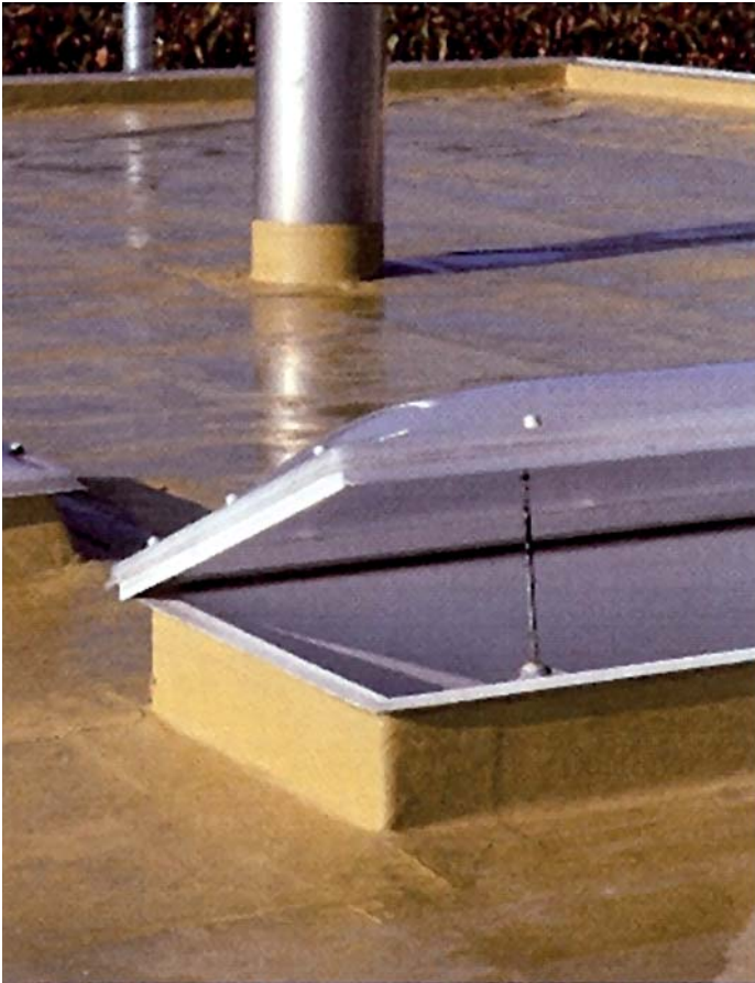
Regelgerechte Abdichtung und Anschluss mit Flüssigabdichtung, Photo : Kemper System Technik
