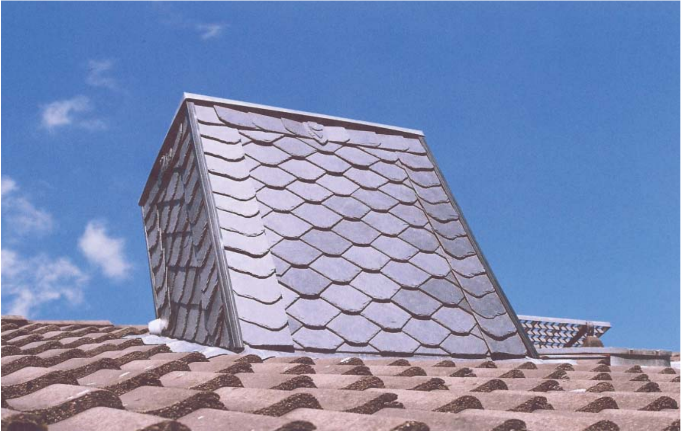
Verkleidung mit Kleinverschieferung auf Lattung mit Wärmedämmung
