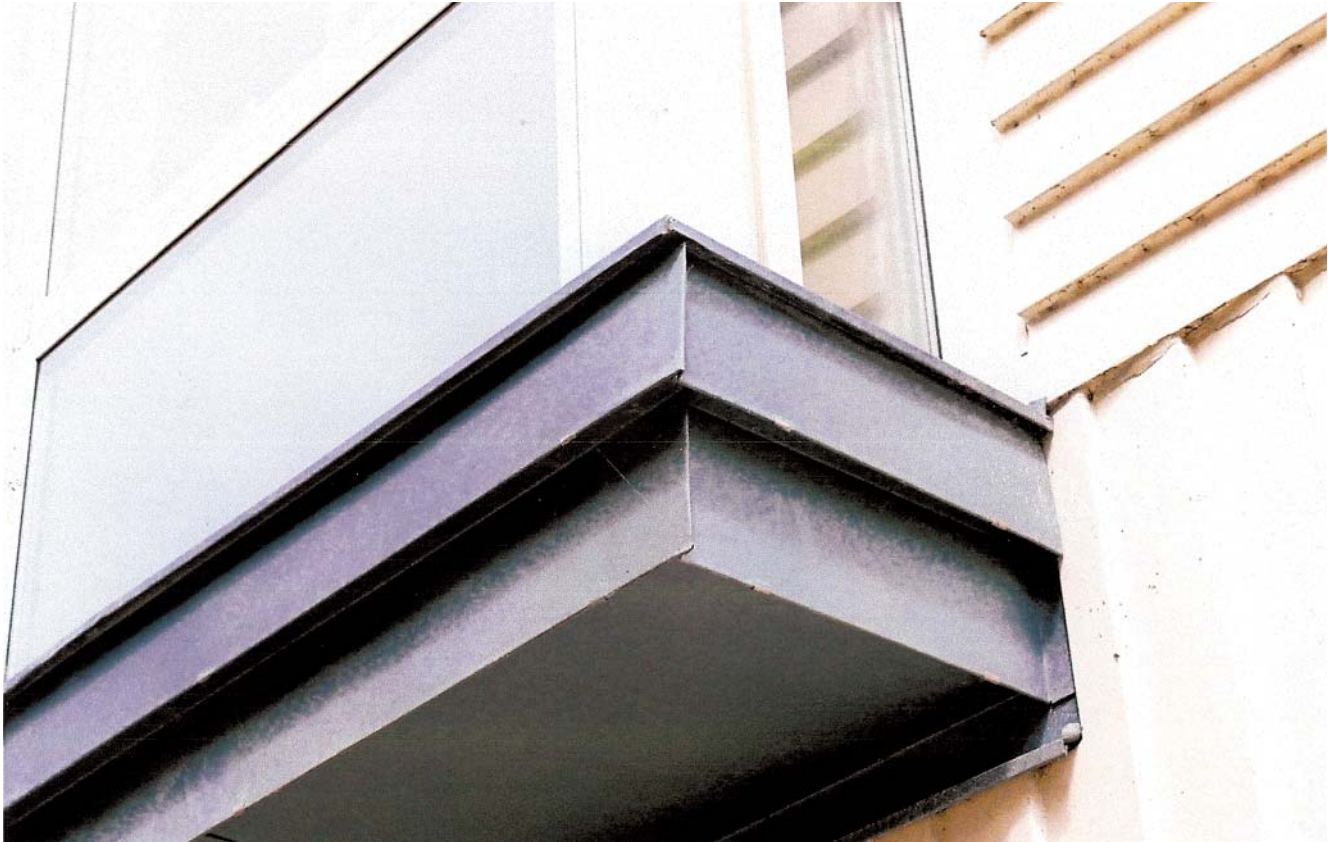
Beispiel der Blecheinfassung mit Falztechnik ohne störende Lötnaht
