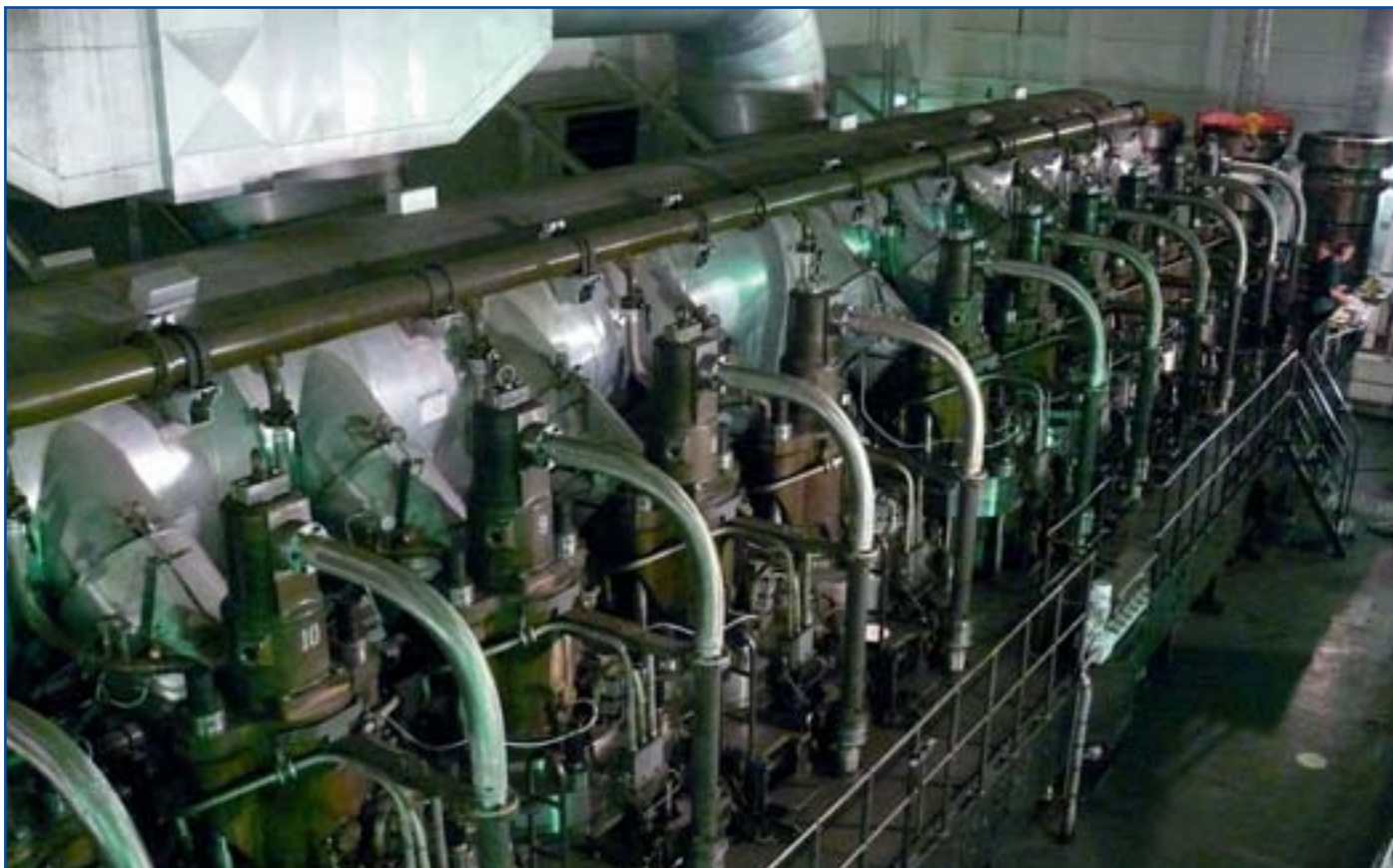
Bei Wartungs- und Instandhaltungsarbeiten kam es zu mehreren Unfällen
