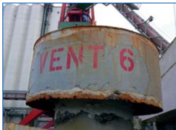
Laderaumlüfterkopf abgerostet
