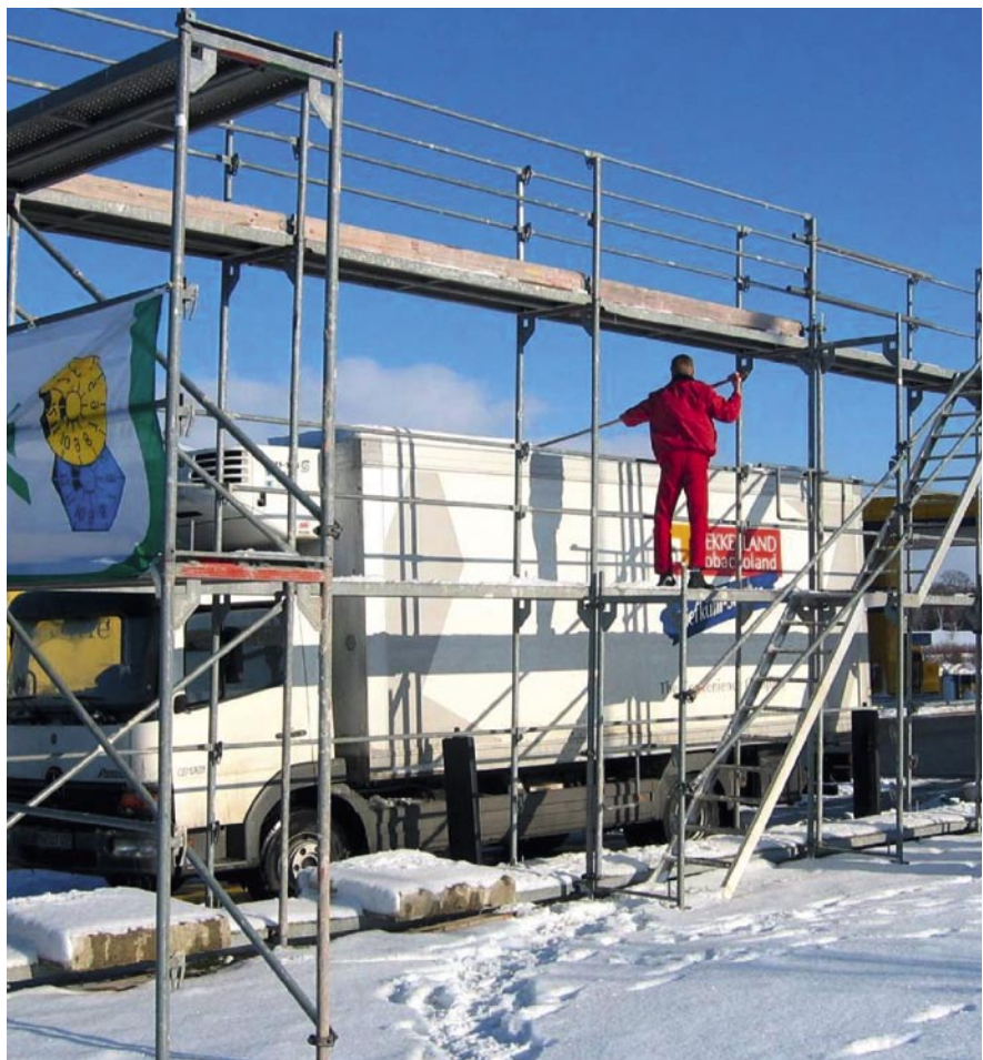
Die sicherste Methode für Fahrer: Entfernen der Dachlasten von einem Gerüst aus
