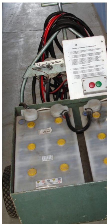
Ein selbst gebautes Starthilfegerät mit Betriebsanweisung und Hauptschalter
