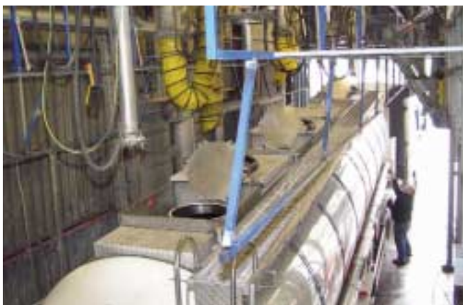
Das neue Geländer bietet mehr Sicherheit vor Absturz
