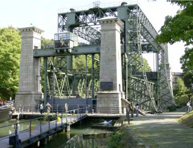
Blick vom Unterwasser auf das Stahlgerüst.
