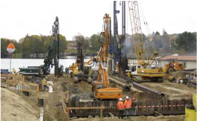
Bauarbeiten an der Schleuse Fürstenberg.
