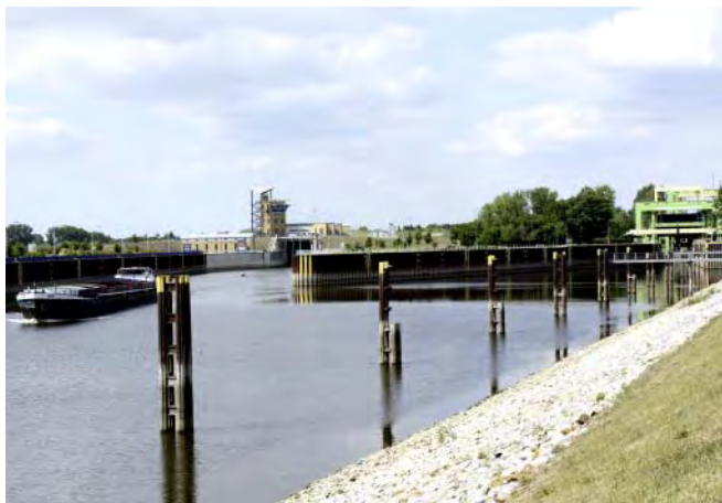
Ausfahrt aus der Sparschleuse.
