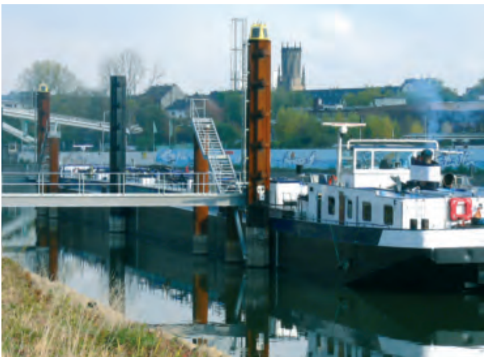
Neue Treppen- und Steigeranlage in Köln-Mülheim.
