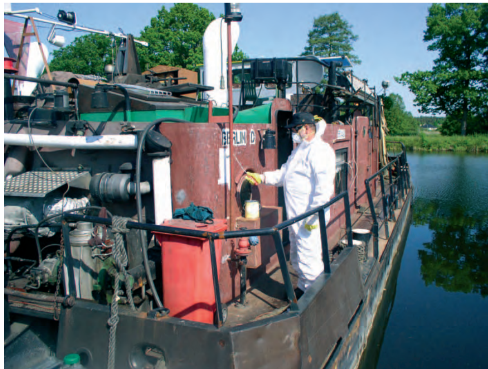
Einweganzug und Maske schützen bei Anstricharbeiten.
