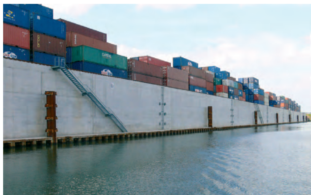
Die Kaimauer im Logport-Hafen ist mit sicheren Treppenaufgängen ausgestattet.
