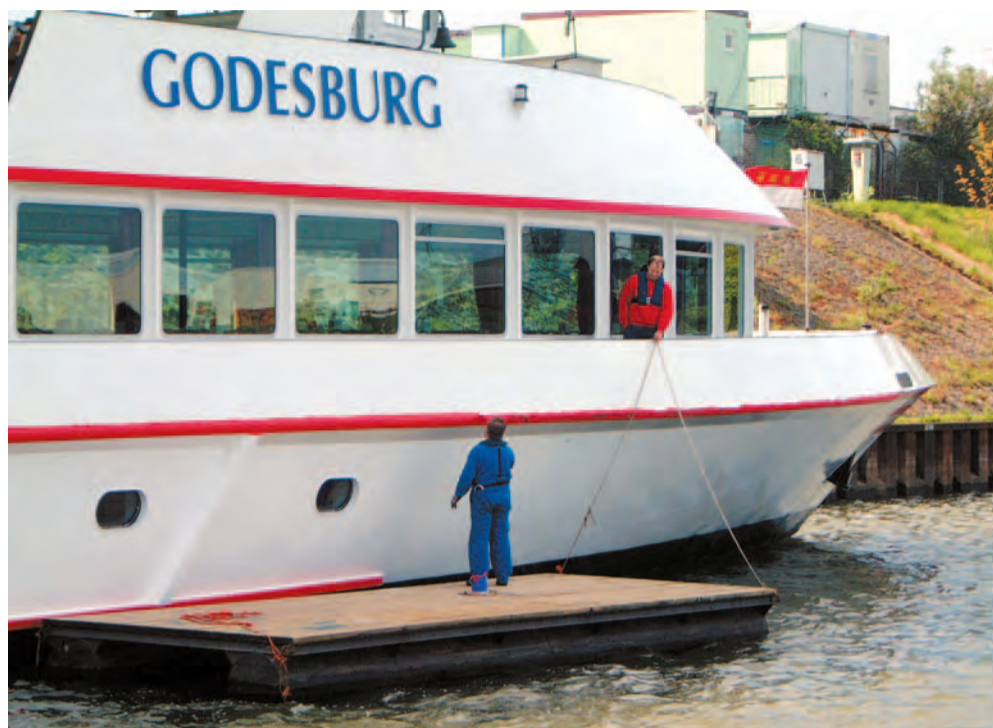
Konservierungsarbeiten stets planen und nur gut geschützt ausführen.
