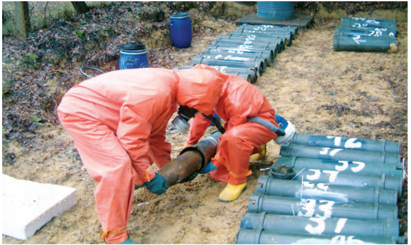
Das Zerlegen von Granaten gehört auch zur Arbeit der Kampfmittelbeseitigung.
