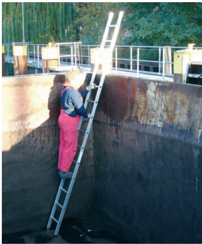
Leitern zum Anlegen müssen um mindestens einen Meter aus dem Laderaum herausragen.
