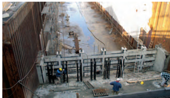
Vorbereitende Arbeiten für den Einbau der neuen Störkörper.
