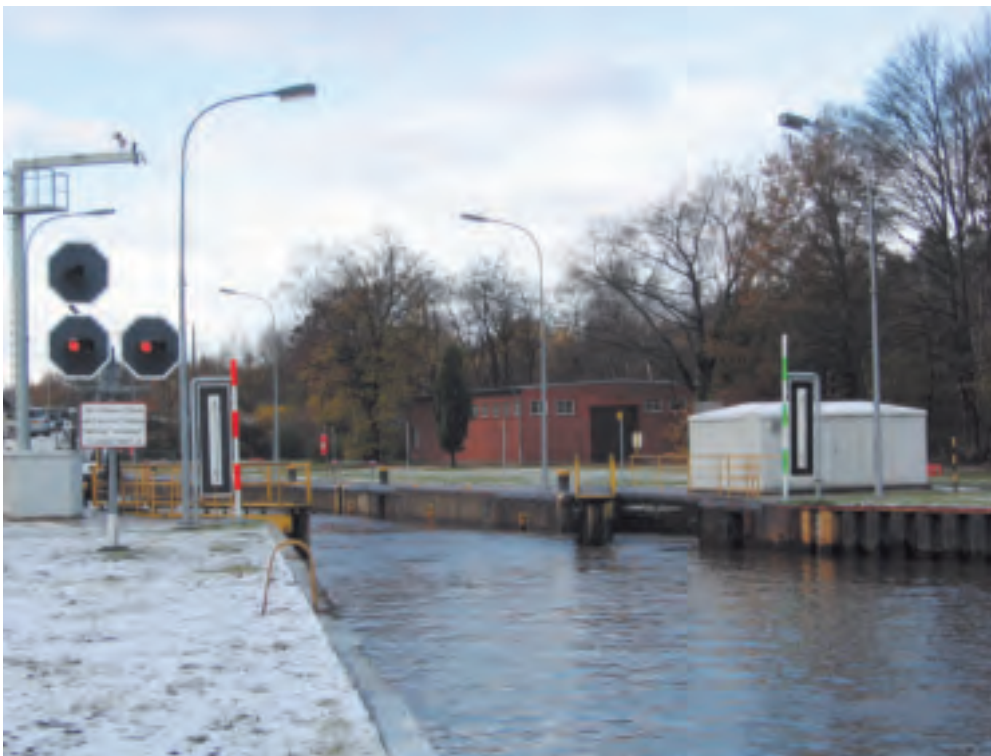
Mit Hilfe der indirekt angestrahlten Tafeln wird die Einfahrt erleichtert.
